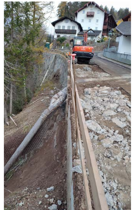
Die Arbeiten zur Sanierung des ersten Teilstücks der Sacunstraße werden im Frühjahr wieder aufgenommen.
