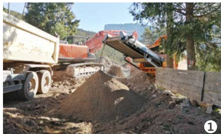
01 Einige Kehren der Forststraße von Martin in Richtung Raschötz wurden ausgebaut. Dabei wurden die ausgehobenen Steine zerkleinert und als Schotter an anderen Stellen der Forststraße genutzt.
