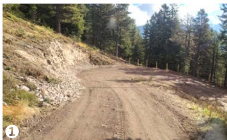
01 Einige Kehren der Forststraße von Martin in Richtung Raschötz wurden ausgebaut. Dabei wurden die ausgehobenen Steine zerkleinert und als Schotter an anderen Stellen der Forststraße genutzt.
