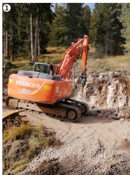
01 Einige Kehren der Forststraße von Martin in Richtung Raschötz wurden ausgebaut. Dabei wurden die ausgehobenen Steine zerkleinert und als Schotter an anderen Stellen der Forststraße genutzt.
